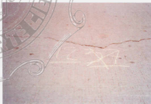
Foto 2. Grieta Longitudinal
