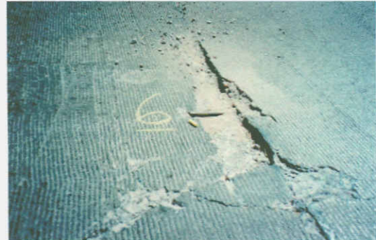
Foto 14. Mala Colocación de Pasajunta. Foto 15. Mala Colocación de Pasajunta.
