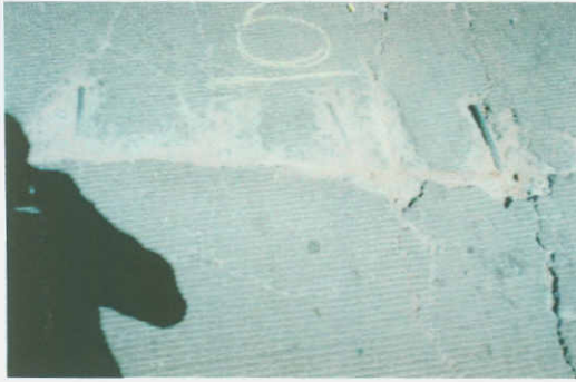
Foto 14. Mala Colocación de Pasajunta. Foto 15. Mala Colocación de Pasajunta.
