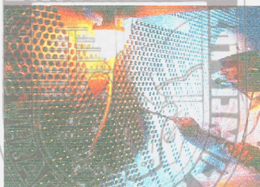
Figura 3-19 Limpieza de los tubos de un condensador para un sistema mayor
